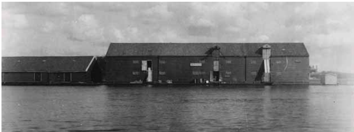
Pakhuis 'Bergen' Foto: GAZ 22.07033
