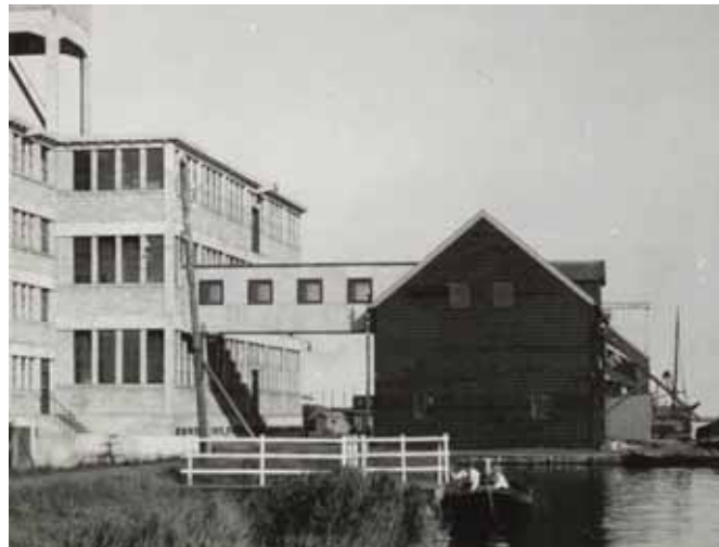
Pakhuis 'Mooriaan' met de luchtbrug naar de nieuwe, binnendijks gelegen, fabriek.
